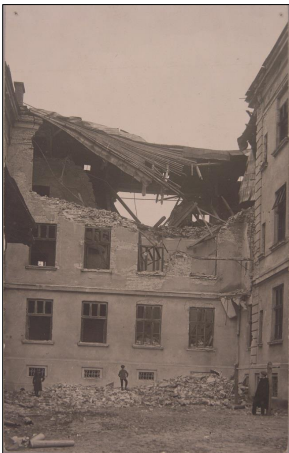
Fot. 68. Szkoła Realna w Tarnowie. Zniszczenia dokonane w czasie bombardowania 26.02.1915 r. Lewe skrzydło szkoły. Część budynku szkolnego w tym sala gimnastyczna były wyłączone z użytkowania
