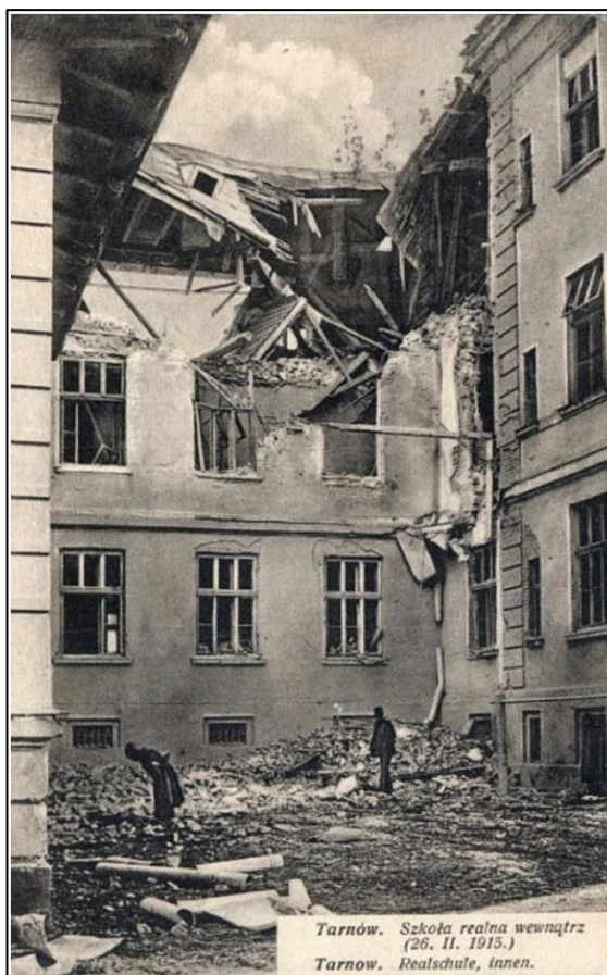
Fot. 69. Szkoła Realna w Tarnowie. Zniszczenia dokonane w czasie bombardowania 26.02.1915 r. Prawe skrzydło szkoły. Część budynku szkolnego w tym biblioteka były wyłączone z użytkowania
